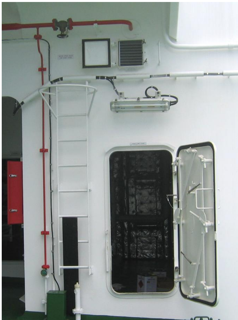
Slika 38 - Izolacijski ventili za raspršivanje morske vode u spremištu za boje
