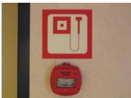
Slika 12 - Vodonepropusni ručni dojavljač
