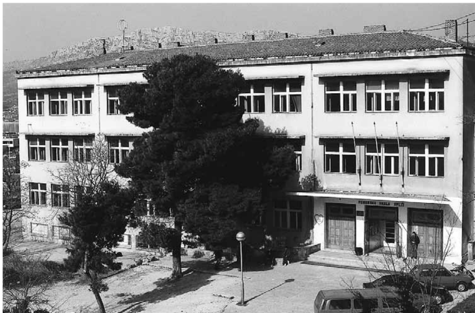
Slika školske zgrade
